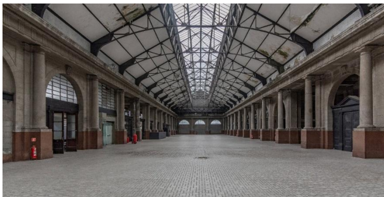
Figura 1: vista interna da gare da estação ferroviária Barão de Mauá, Leopoldina, cobertura atual, tesouras metálicas e claraboia central.
