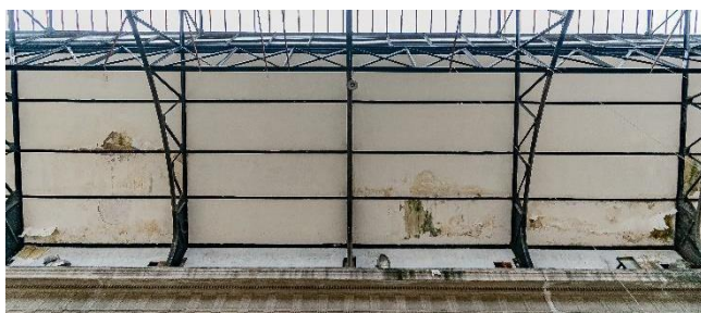
Figura 5: detalhes do forro da gare com deslocamento de pintura, mofo e bolor.
